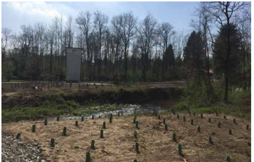
In alto. Cavalcavia di Autostrada Pedemontana Lombarda
