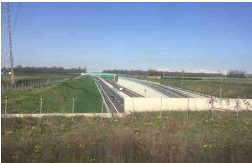
A fianco, Autostrada Pedemontana Lombarda
